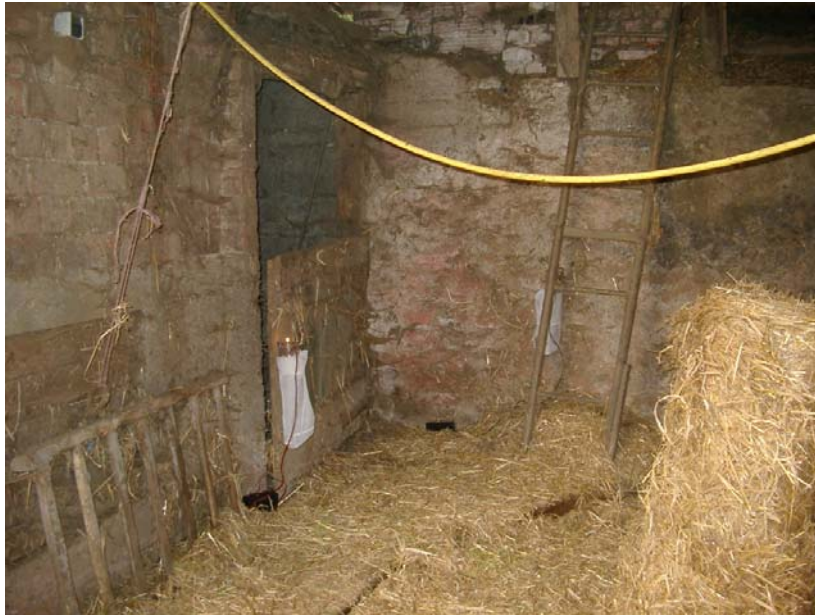
Abbildung 40 Foto eines Verschlags hinter dem Kuhstall
