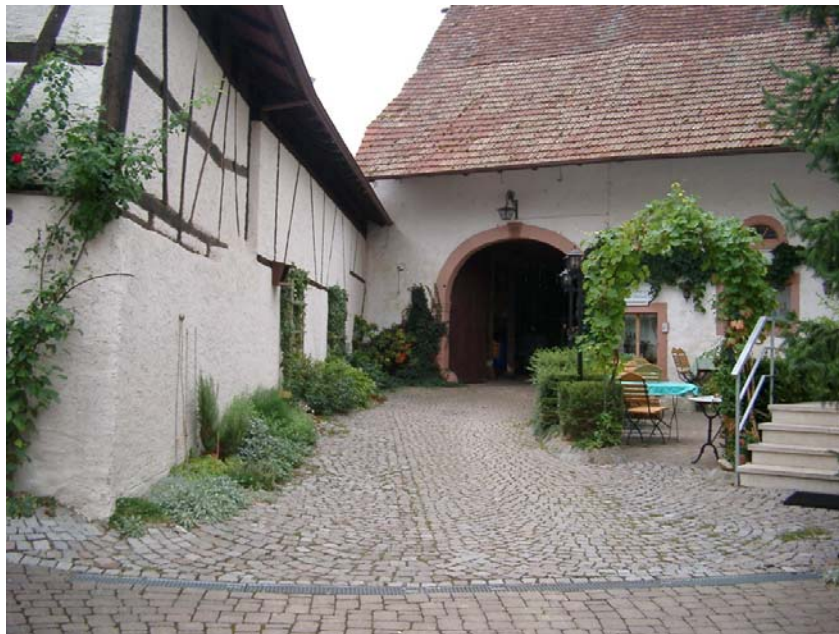
Abbildung 36: Foto der Scheune des Hotels Rebstock
