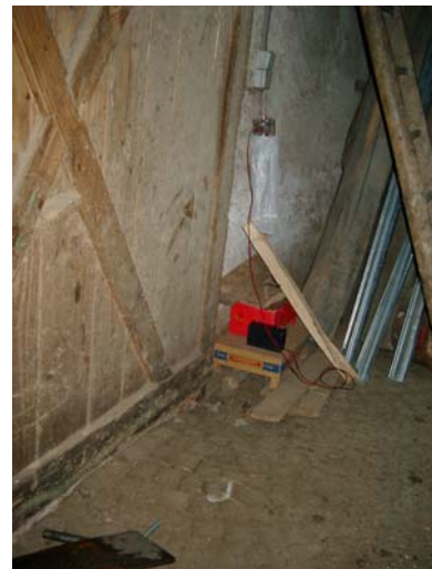
Abbildung 28: Foto des linken Teils der Scheune
