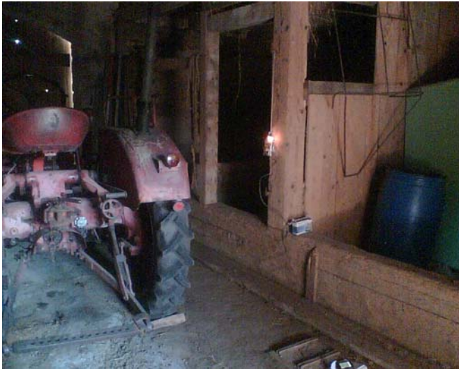
Abb.9: Holzschuppen in Eschbach- Rebweg 1
