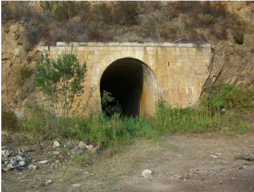
Abb.23: Foto des Tunneleingangs
