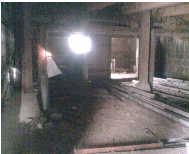
Abb.14: Innenansicht der Scheune in Feldkirch
