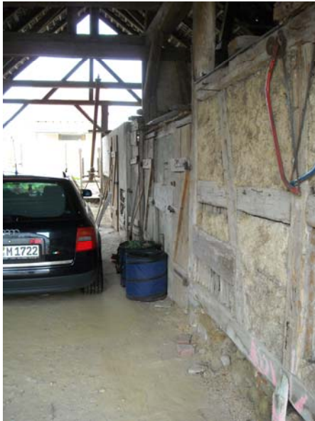
Abb.10: Foto des Schuppeneinganges in Eschbach- Hauptstr. 55
