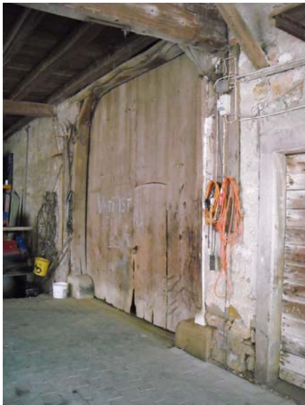
Abb.8: Eingang zur Scheune in Auggen
