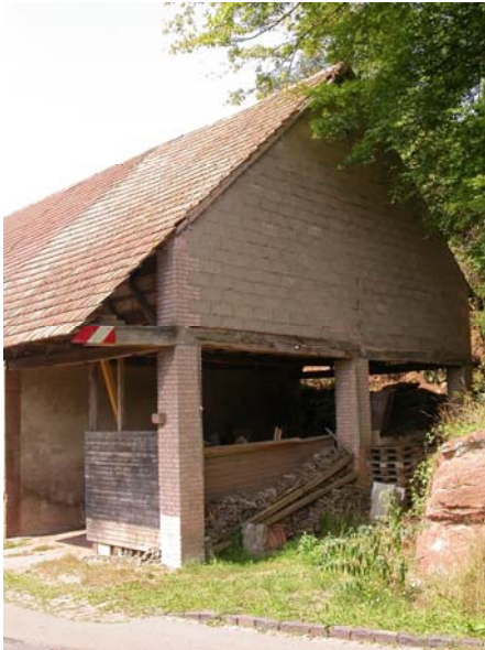
Abb.22: Scheune in Nanzdietschweiler
